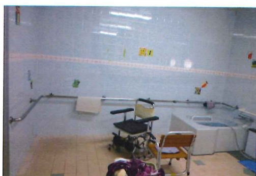
9月 浴槽手すり工事
